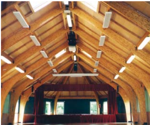
EZ200 gibt direkt Wärme ab, ein Vorheizen ist nicht nötig. Dadurch eignet sich das Gerät besonders für Gebäude, die nur in unregelmäßigen Abständen genutzt werden.
